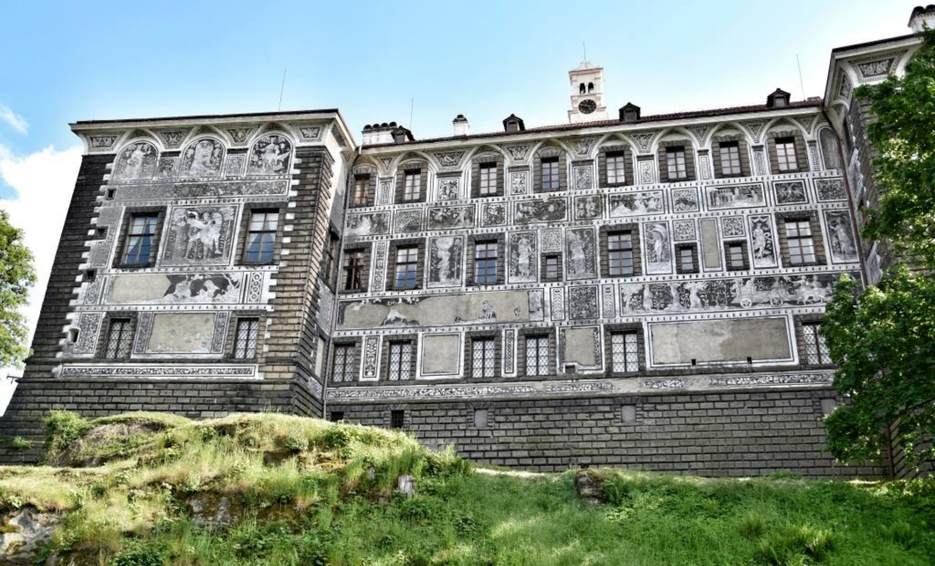
Pohled na severní stranu zámku se sgrafity
